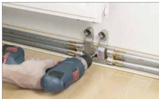
Рис. 16-35 Закрепление крестовины SL-RAUTITAN
