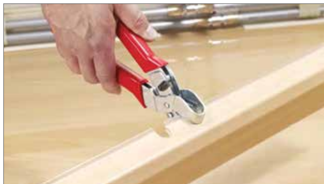
Рис.16-46 Вырезка полукруглых отверстий в крышке плинтусного канала
