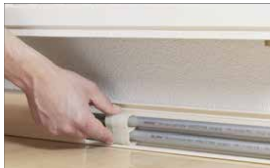
Рис.16-36 Установка фиксаторов труб отопительной разводки
