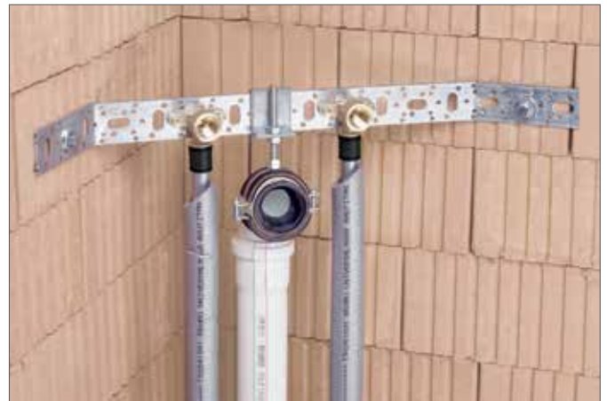
Рис. 5-3 Пример монтажа кронштейна
